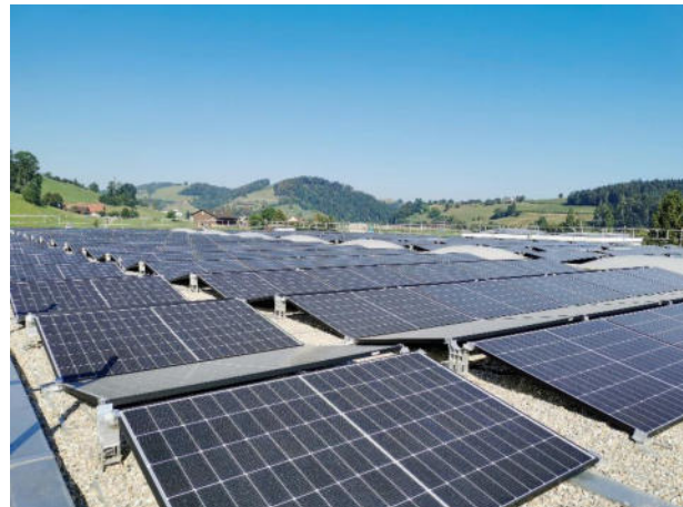
Vorher – nachher: Die Photovoltaikanlage auf den bisher ungenutzten Flachdächern der Macchi Beton-Fertigteile AG hat eine Leistung von 380 kWp. Der Strom wird direkt ins nahe Kies- und Betonwerk geleitet.
