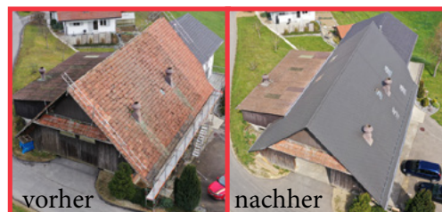
Ausgeführte Steildach- und Spenglerarbeiten
